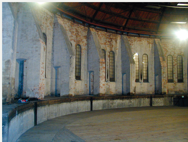
Figur 2. En av gasklockorna inom Gävle gasverk.
